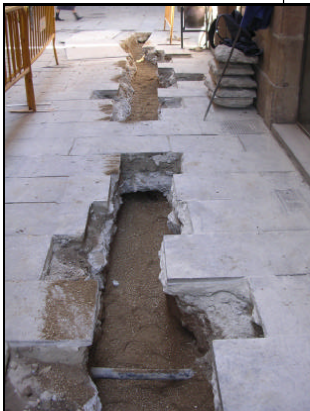
Foto.5: Detall del tram de rasa del carrer d'Esparteria ja finalitzada.
