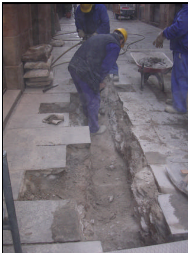
Foto.2: Detall dels treballs d'extracció del formigó en el tram de rasa del carrer d'Esparteria.
