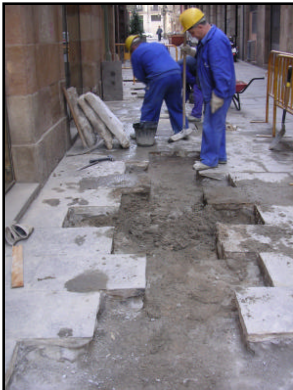
Foto.7: Treballs de col.locació del formigó en el tram de rasa del carrer d'Esparteria.
