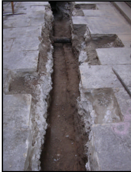
Foto.3: Detall del tram de rasa del carrer d'Esparteria un cop oberta.
