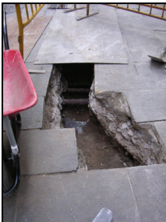
Foto.1: Detall del primer tram de la rasa ja obert.
