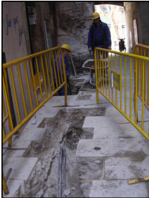
Foto.9: Detall del tram final de la rasa del carrer Formatgeria.
