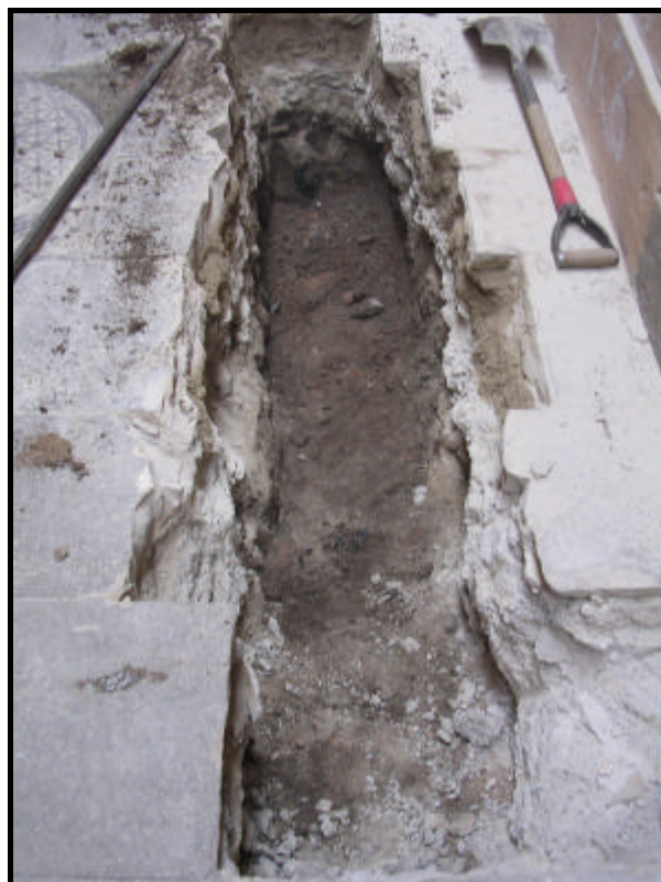
Foto.8: Detall de la rasa del carrer Formatgeria un cop oberta.
